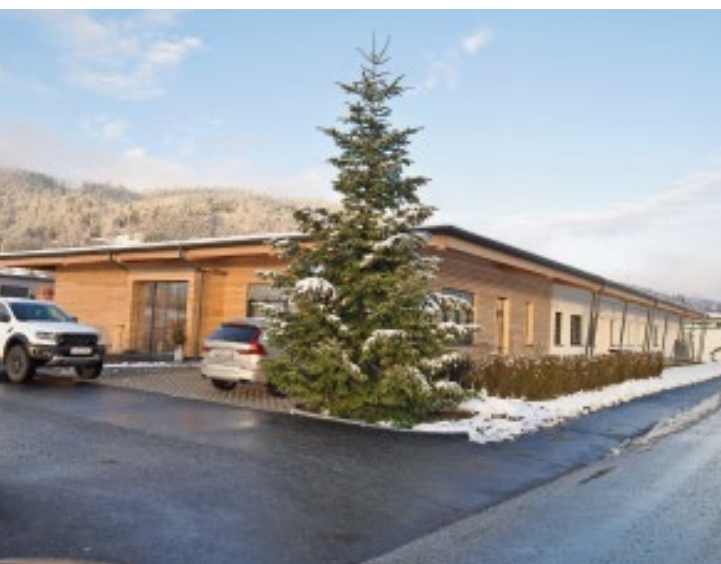
Der gesamte Betrieb der Fleischerei Pierer samt Geschäft wurde am Rand von Passail im Gewerbegebiet neu errichtet.
