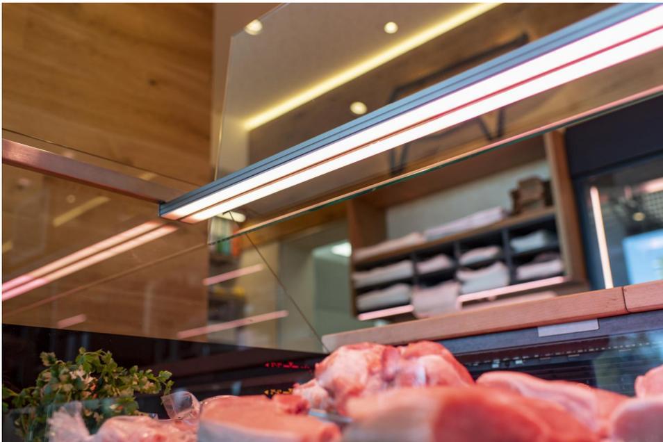
*Ideal ist eine die Kühltheke integrierte LED- Beleuchtung. Diese emittiert wenig IR- und UV-Strahlung, zudem entsteht an der Lichtaustrittsquelle keine Wärme. © Aichinger*
