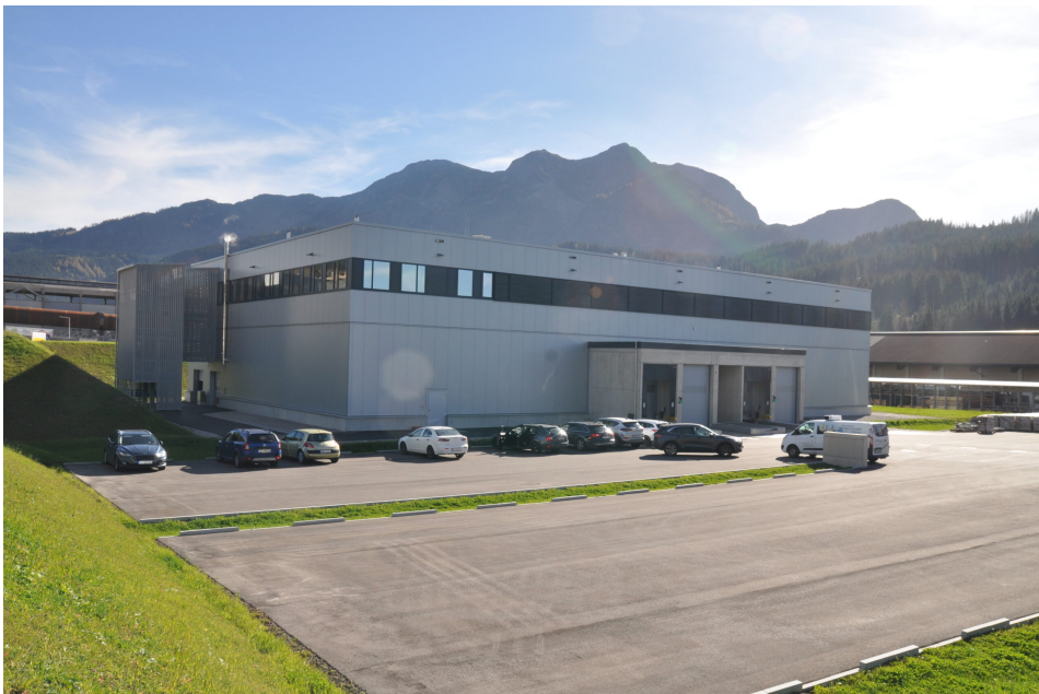
Horngacher-Gebäude in Hochfilzen. Wie es für die Beschäftigten und das Anlagevermögen der Horngacher GmbH weitergeht, liegt nun in den Händen des Insolvenzverwalters. © HaRo
