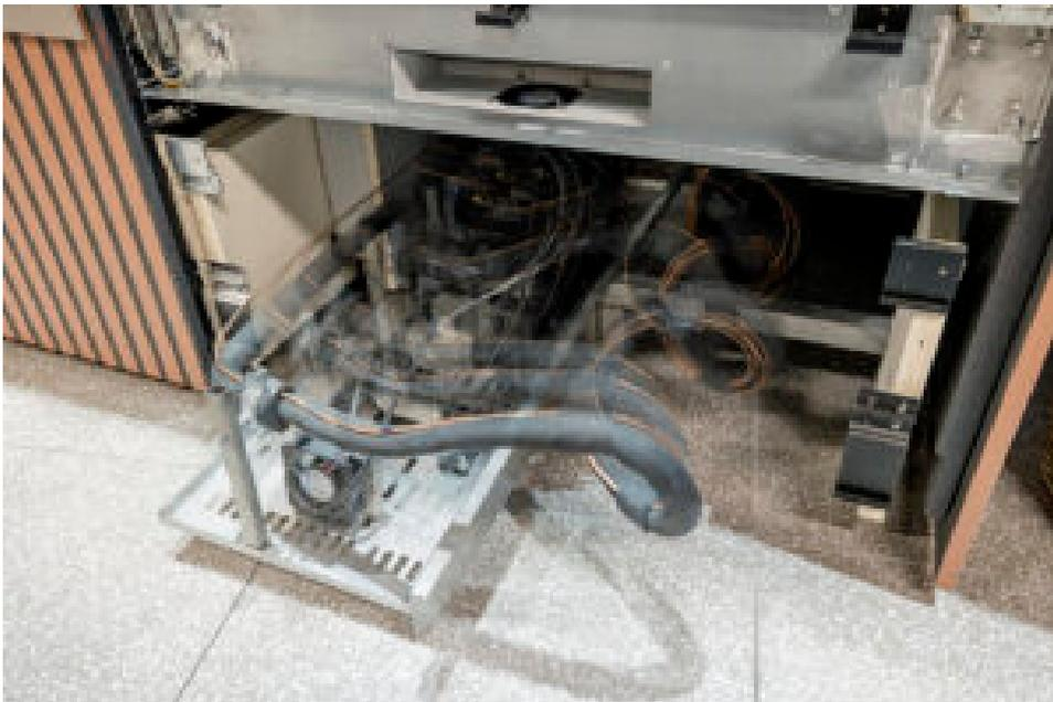
*Kühltheke mit integrierter Kälteanlage Alternativ zu einer stationären Kälteanlage werden Kühltheken und -möbel mit integriertem Propan-Kältesatz angeboten. In diesen Geräten sind bereits kleine Kälteanlagen integriert. Aichinger bietet ab Juli die Kühltheke Sirius Pin auch mit dieser Technologie an. © Beigestellt*
