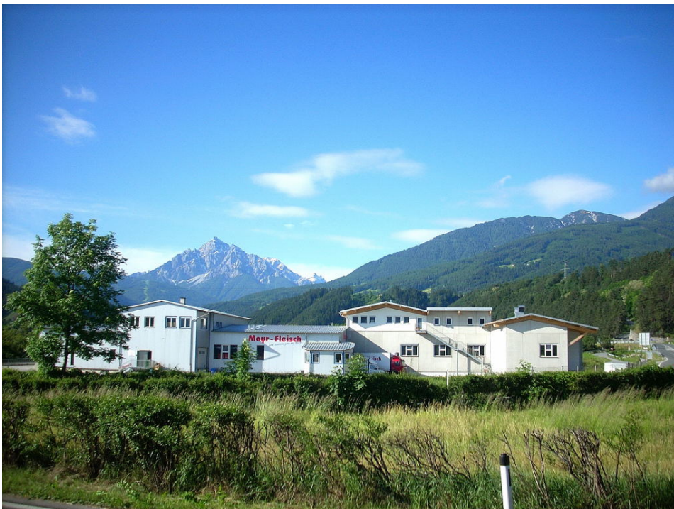
Fleischerei Mayr in Natters bekam eine neue Räucher- und Reifeanlage von Tribus. © Beigestellt
