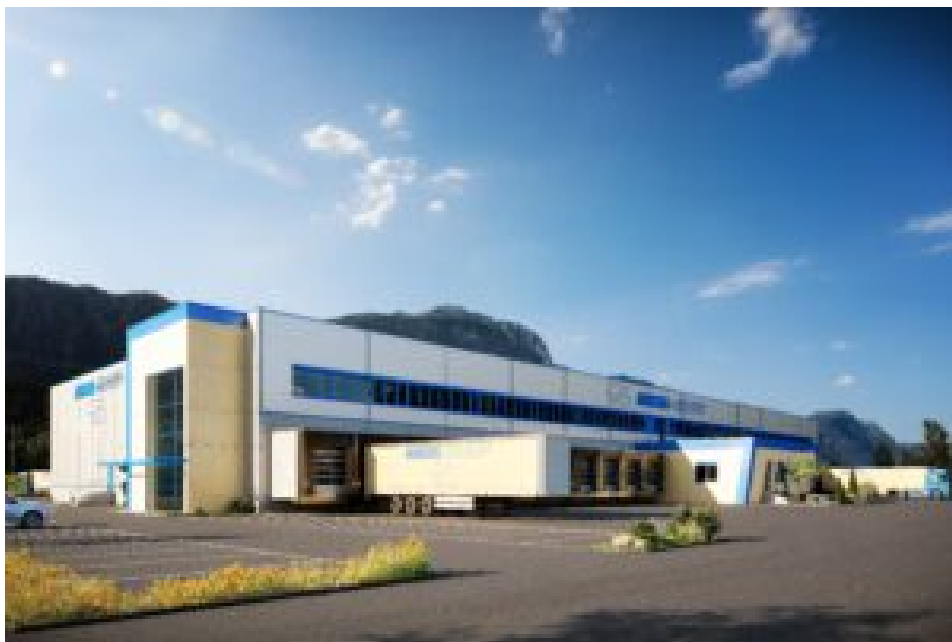
In Radfeld im Tirol baut die Nagel-Group einen modernen Logistikstandort. (©Nagel-Group)
