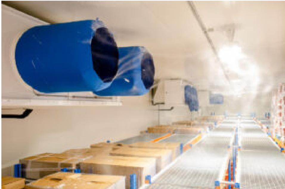
*Der Einsatz von Luftsäcken im Kühlager, um beim Abtauen Energie zu sparen. © Karin Bergmann*
