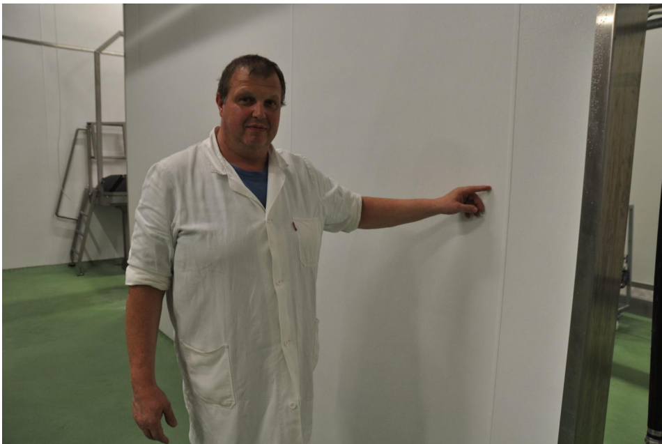
Bei der Fleischerei Böck wurden in der ersten Bauphase die Wandverkleidungen mit großformatigen Glasbord®-GFK-Paneeelen verkleidet. © Gasselich
