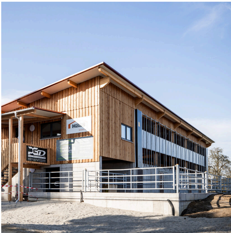
Der neue Tierwohlstall ist von HAAS gebaut. © Haas
